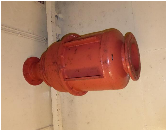
explosieventiel invoer buitenlucht
