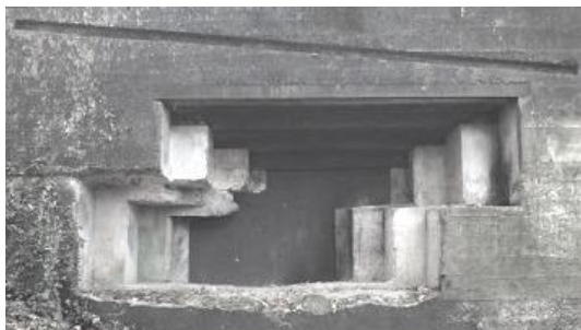
← de typische vorm van het oorspronkelijke schietgat
