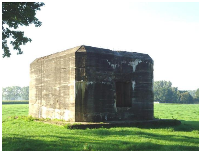
de achterzijde (noordgevel), met z'n verhoogde toegangsdeur
