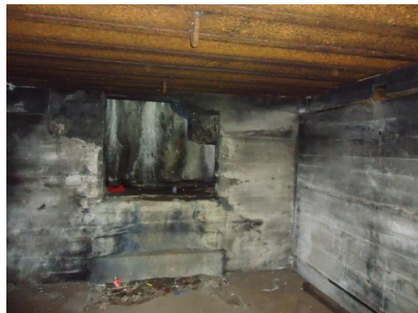
de geschutskamer met z'n stalen plafond, boven nog een hijssoog voor de plaasting van het kanon
